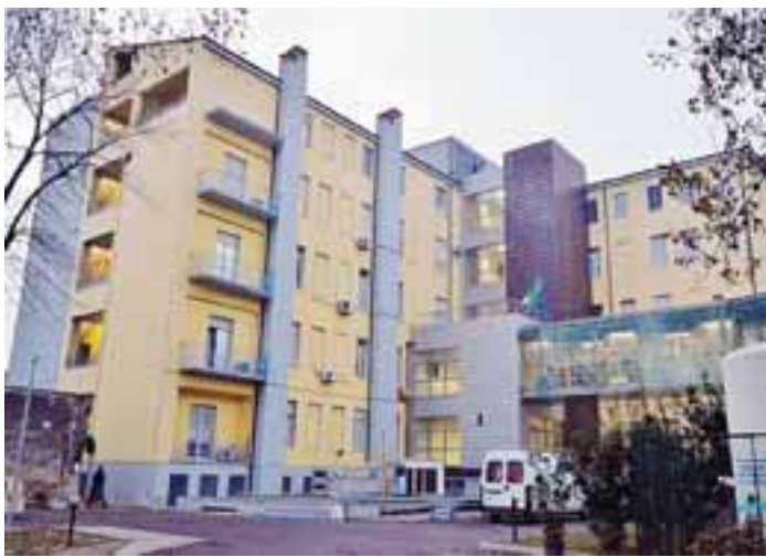
Progetto per l'ospedale: un cantiere sul blocco A, uno per abbattere il blocco B
