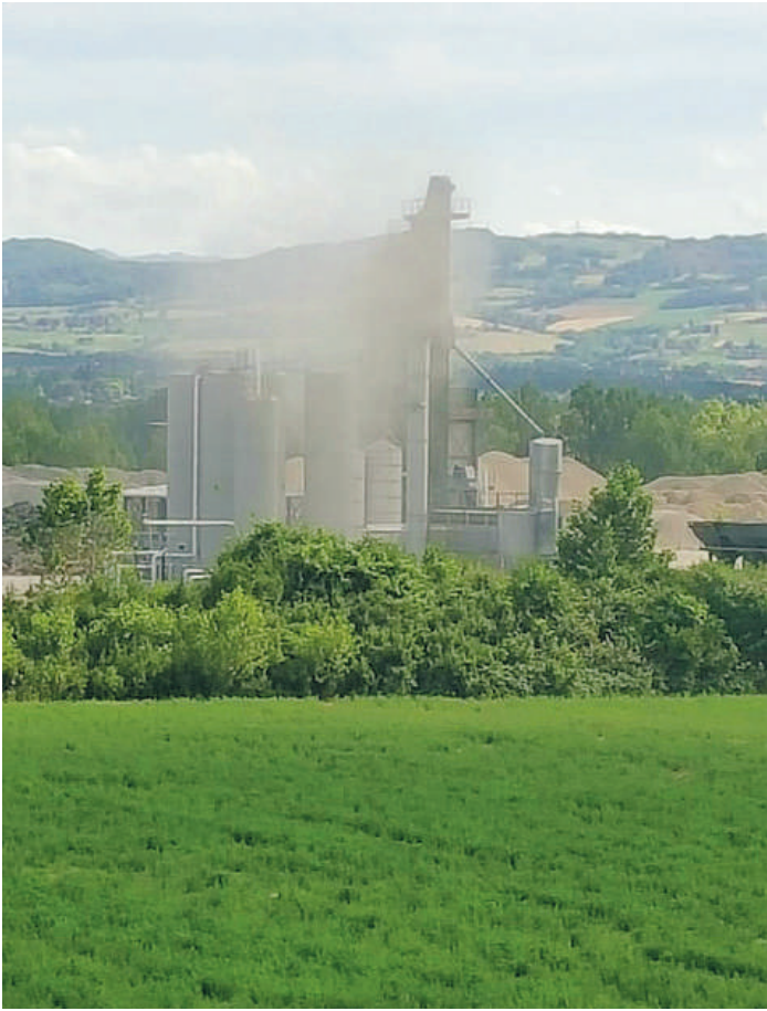
L'impianto di produzione di conglomerati bituminosi a Pontenuovo
